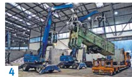
**4** Bei der Zerlegung wurde die Größe der Bauteile von der Demontagecrew vorgegeben. Sie durften nur so groß und schwer sein, dass sie von Tiefloadern abgeführt werden konnten.
