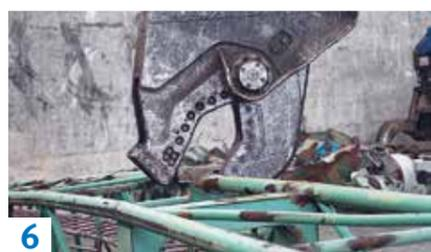
**6** Die Stahlteile wurden mit dem Beiß-Bagger auf max. acht Meter Länge gezwickt ...
